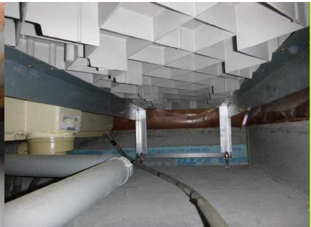
写真2. 床下状況 居住部
