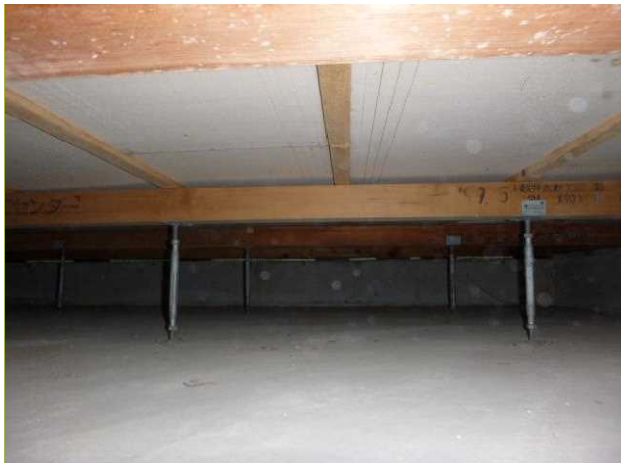
写真1. 床下状況 基礎際部
